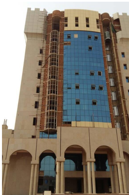
شكل (٣١) يوضح الواجهة أثناء تركيب المواد عليها
